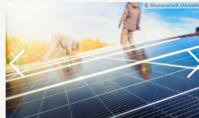
Installation Solarmodule auf Dach
